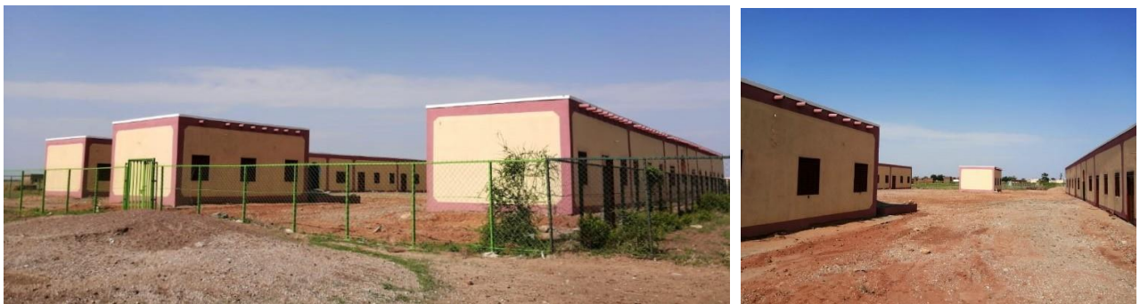
Hilat Al Bir: Die neu gebaute Basisschule mit 8 Klassenzimmern, 3 Lehrerbüros sowie einer Teeküche.
