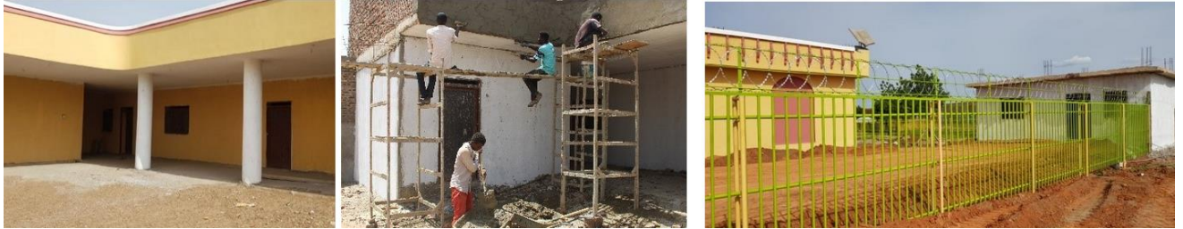
Die neu gebaute Gehörlosenschule besteht aus acht Räumen sowie 2 Lehrerbüros, einer Teeküche und Toiletten.
