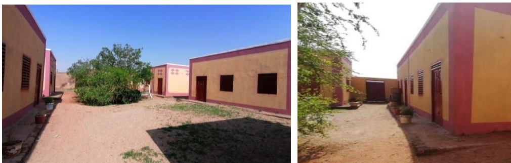
Hilat Al Bir: Der Kindergarten ist durch 4 Gruppenräume, einen Büroraum sowie eine Teeküche erweitert worden.
