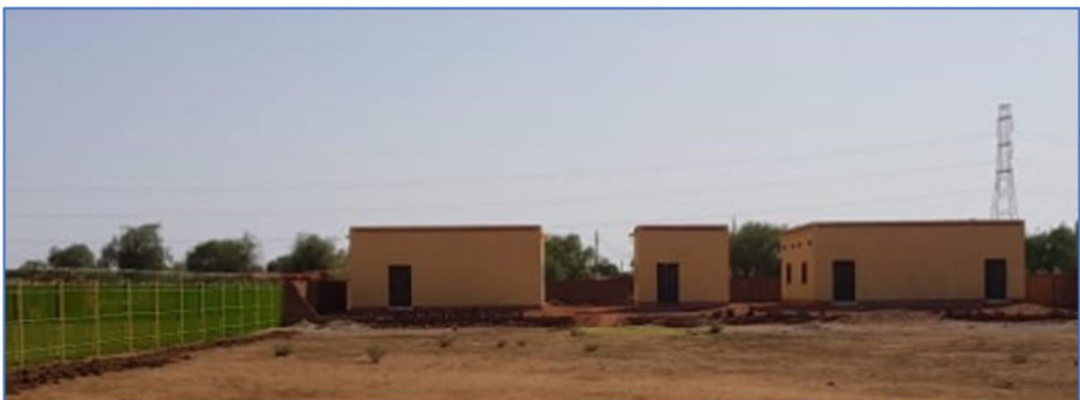
Links im Bild sind zwei Büroräume, in der Mitte die Küche, rechts der große Versammlungsraum mit ca. 120 qm. Große Versammlungen und Veranstaltungen können auch auf dem ca. 3500 qm großen umzäunten Gelände stattfinden.
