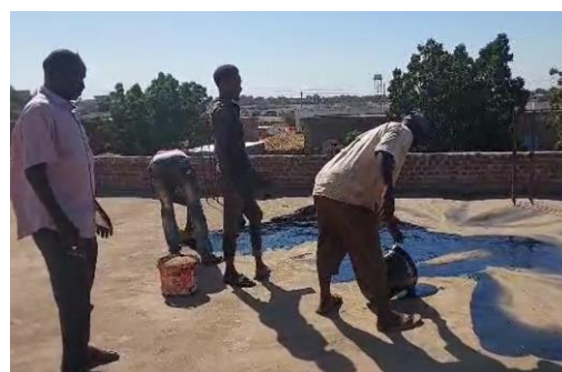
Renovierung der Gehörlosenschule und Isolierung des Daches (700 qm) mit Bitumenschicht
